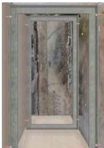
fotomontaggio dell'interno di uno degli altari minori post-intervento con la struttura in acciaio e la muratura ripristinata
